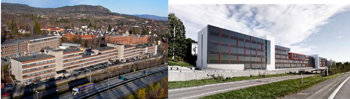
Photo: Moderne Byggfornyelse
