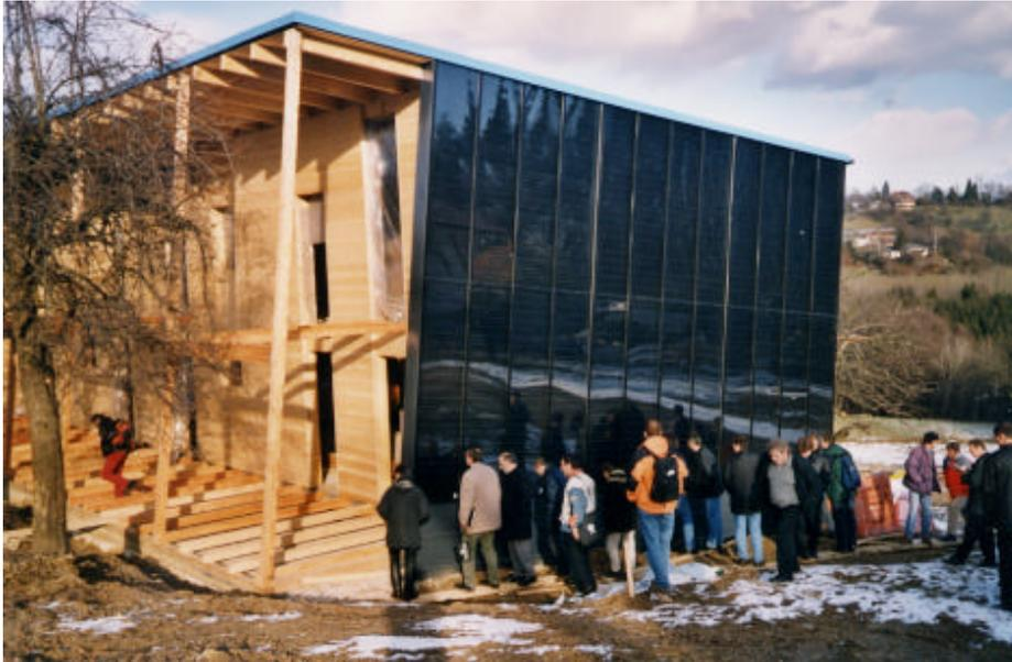
Abbildung 6: Testfassade, 55 m<sup>2</sup> Bruttokollektorfläche, 3570 l Schichtspeicher, 500 l Brauchwasserspeicher
