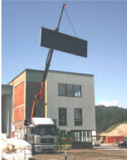
Abbildung 10: Kranmontage des Versuchskollektors auf eine Ziegelwand, Ansicht der Südfassade des Verwaltungsgebäudes
