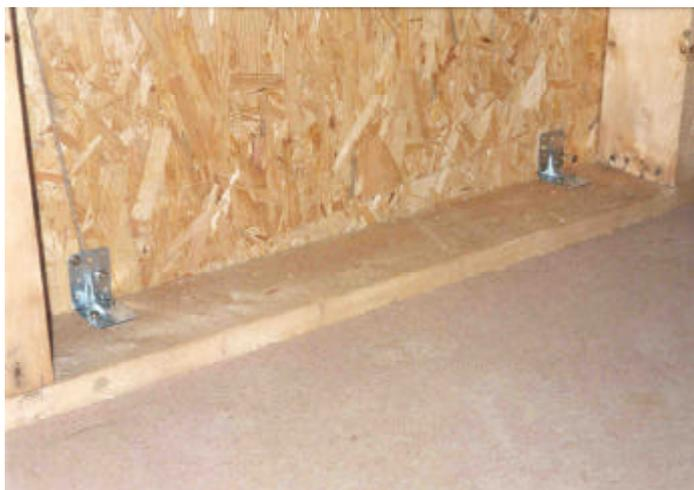
Abbildung 8: Befestigung der Kollektorrückwand (OSB-Platte) an den Holzriegeln der Wandkonstruktion mit Stahlwinkeln
